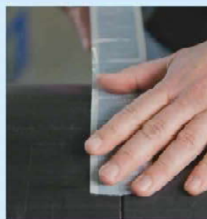
Загерметизируйте соединительную поверхность между фитингом и трубой с помощью уплотнительной ленты и произведите усадку термоусадочных рукавов.
