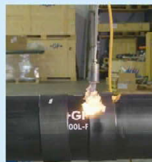
Загерметизируйте соединительную поверхность между фитингом и трубой с помощью уплотнительной ленты и произведите усадку термоусадочных рукавов.
