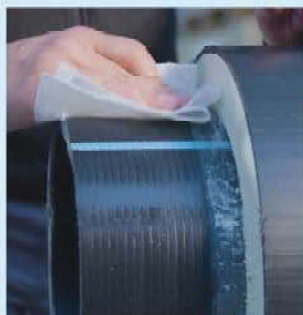
Очистите концы трубы и фитинга типа В и очистите зоны сварки, используя чистую ткань.
