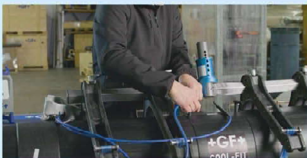
Подсоедините сварочные кабели сварочным контактам фитинга и выполните сварку в соответствии с инструкцией по эксплуатации.
